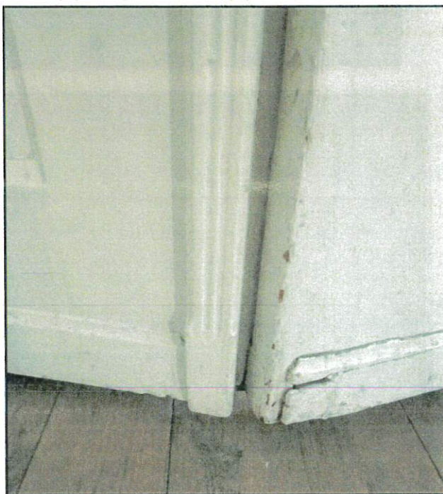
24. Fotografie wewnętrznej stolarki drzwiowej prezentującej różnorodność form, a także spójność detalu w formie pionowych i poziomych żłobień.
