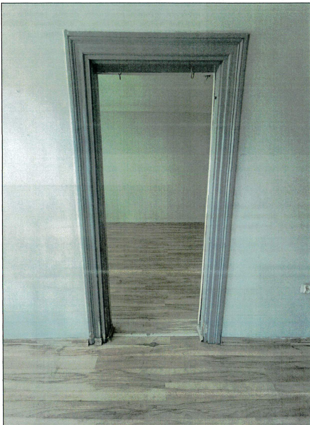
26. Fotografia jednej z profilowanych zachowanych maskownic stolarki drzwiowej wewnętrznej.
