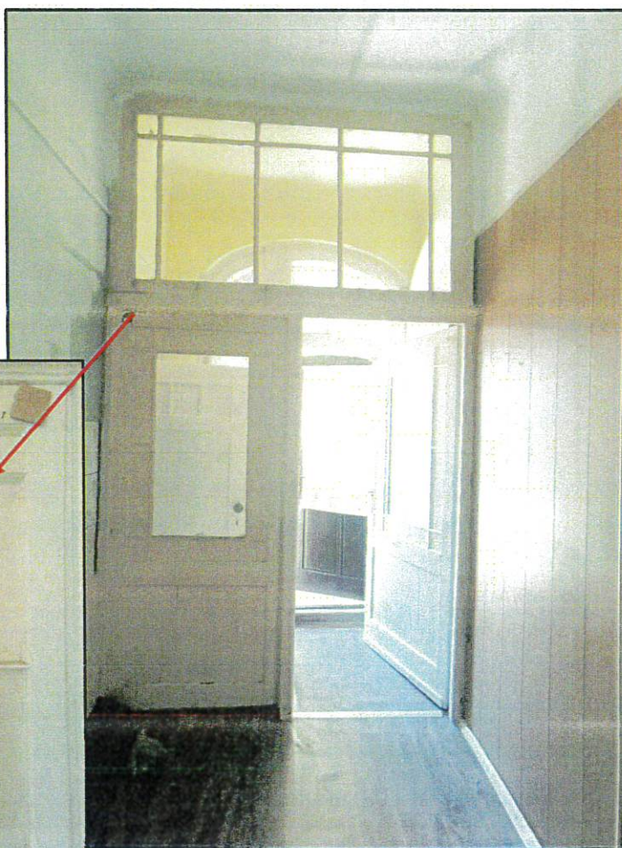
28. Widok ogólny na stolarkę drzwiową przedsionka wraz ze zbliżeniem na dekoracyjne szkło groszkowane zachowane w szkleniu drzwiowym.
