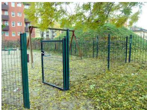
Istniejące ogrodzenie obecnego placu zabaw do rozbiórki
